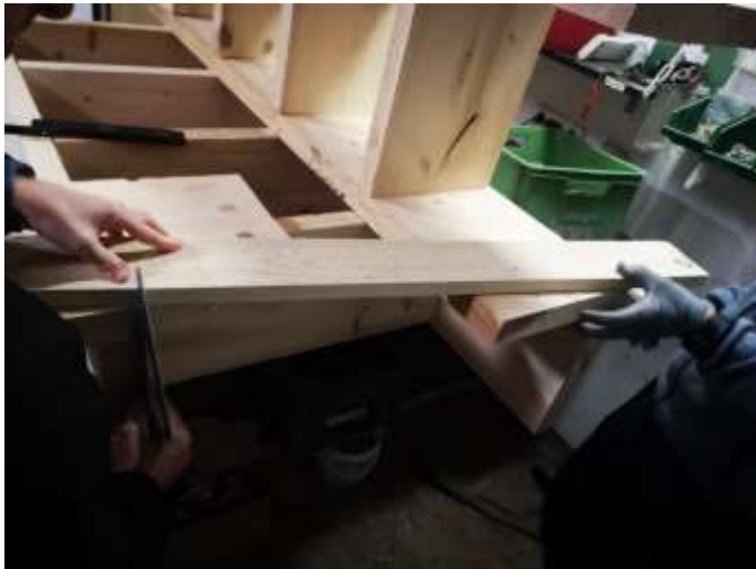
Abbildung 7: Anzeichnen der für das Dach benötigten Schräge mithilfe eines zusätzlichen Brettes
